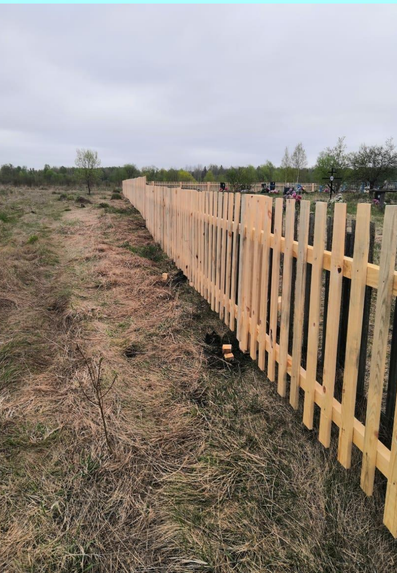
Устройство ограждения кладбища из штакетника в д.Старосайнаково
