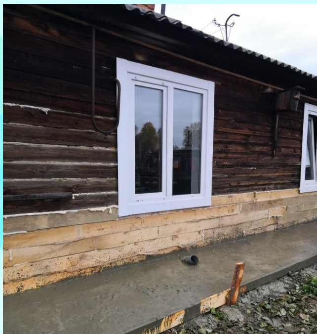
Ремонт муниципального жилья (80 тыс.руб.)
